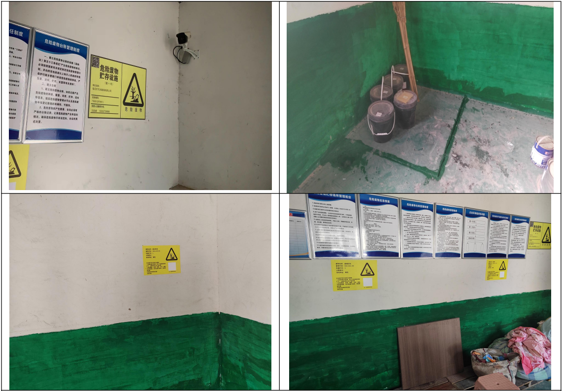
危废间内部照片
